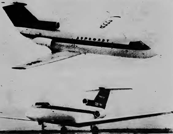
Avion Tri-jet sovietico nobo pa transporte de pasahero a ser exhibi recientemente y a cuminsa bula abaxa na Rusia. Number di e avion ta YAK-40 y ta un diseno di Alexander Yakovlev. E avion por transporta 24 pasahero y tin un velocidad di 750 kilometer pa ora. - UPI Radiophoto.
